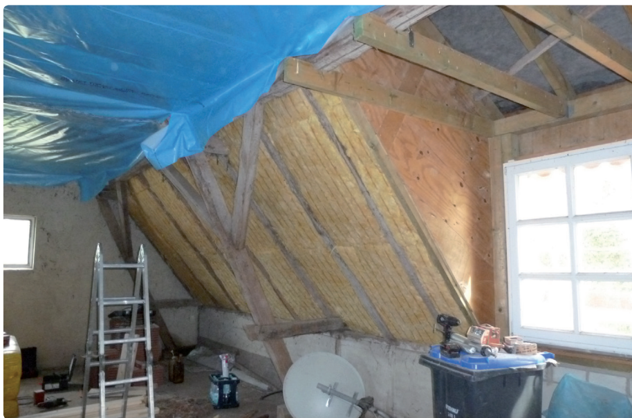
Örtliche Betriebe haben die Dach- und Wanddämmung fachgerecht vorgenommen.
